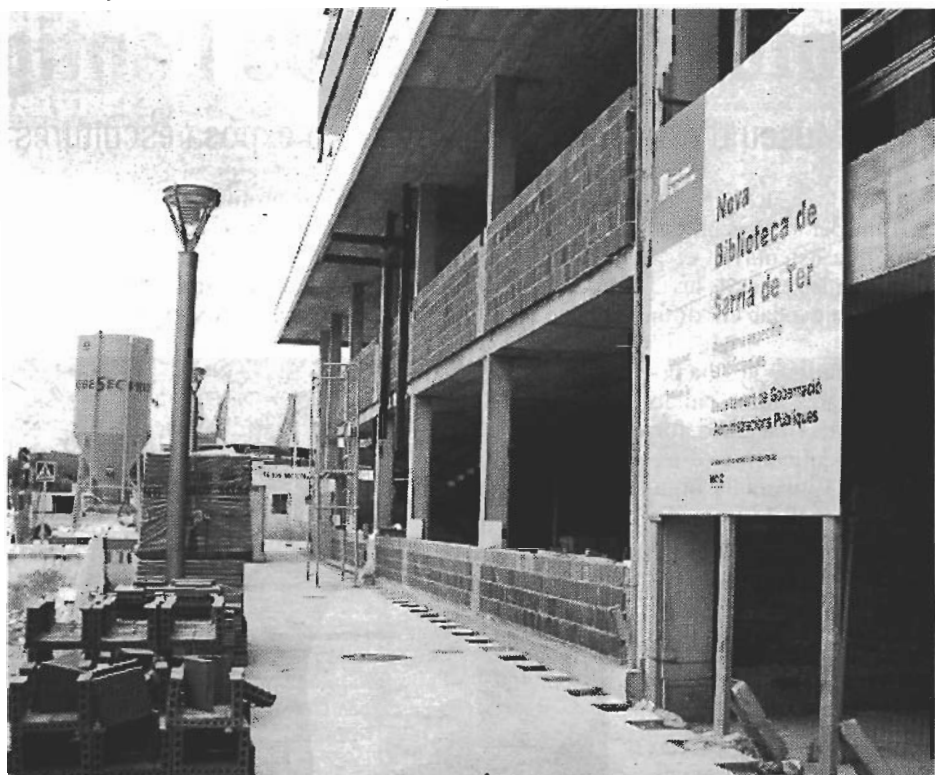
Les obres de la nova biblioteca, als antics terrenys de la Coca-Cola. / D.V.
