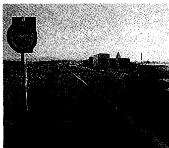
► N-II a Maçanet. L'alcalde, Antoni Guinó, considera vergonyós l'abandó i l'estat en què es conserva la N-II: «Cal prendre mesures dràstiques contra l'alta sinistralitat». Reclama el desdoblament urgent. /A.P.
