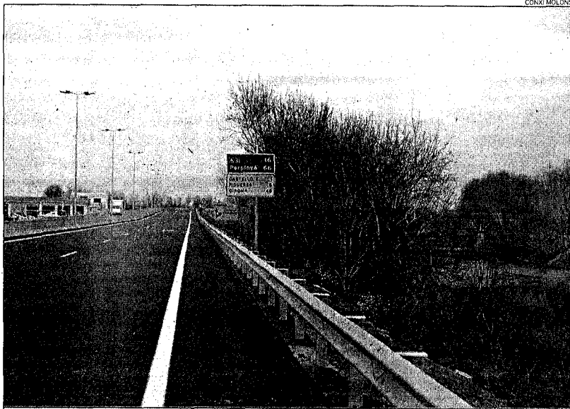
Nous accessos. El desdoblament de la C-260 comporta canvis en els accessos i la construcció d'un nou.
