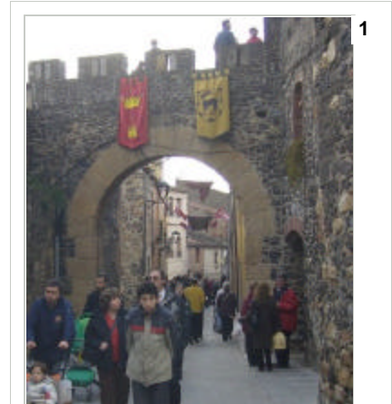
Detall del recinte del castell. Foto: J.C.
