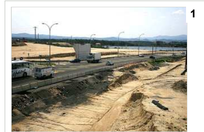
1 Les obres de l'N-II a Caldes, que també estan aturades. Foto: M.LLADÓ.
