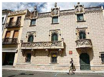
Detalls dels danys soferts en els ornaments de la façana. aniol resclosa
