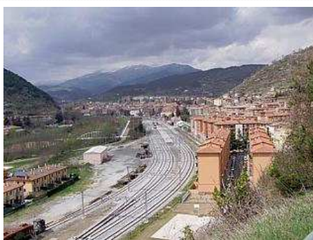
Les instal·lacions ferroviàries separen dos barris de Ripoll. X.V.
