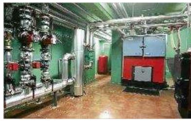
Aspecte de la sala que acull una caldera de biomassa. diari de girona
