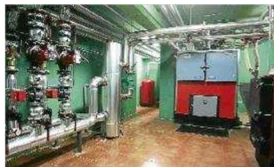
Aspecte de la sala que acull una caldera de biomassa. diari de girona
