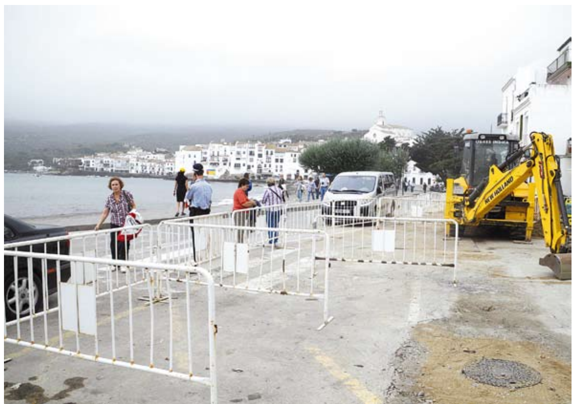
UN ALTRE COP EN OBRES. Des del passat 20 de setembre, el centre de Cadaqués torna a tenir màquines treballant
