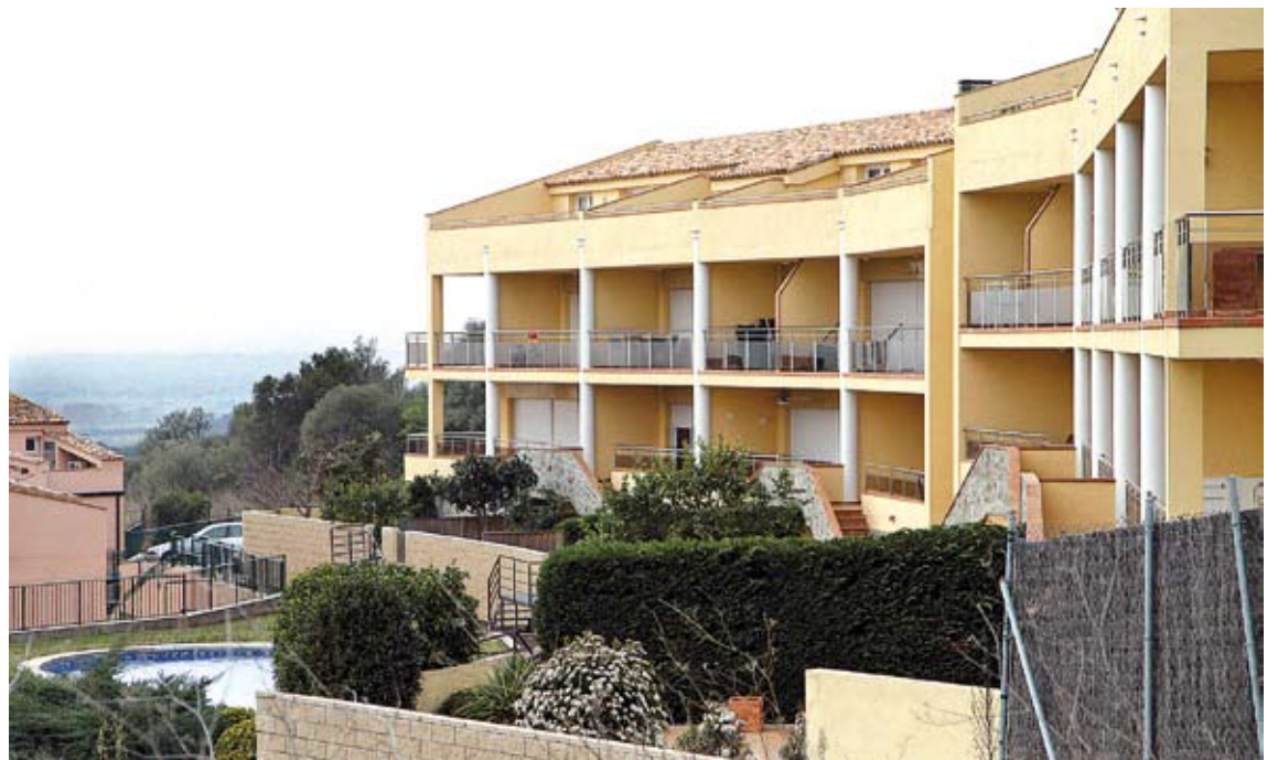
SUN VILLAGE. Una sentència ferma obliga a enderrocar el complex per no adequar-se a les normes urbanístiques
