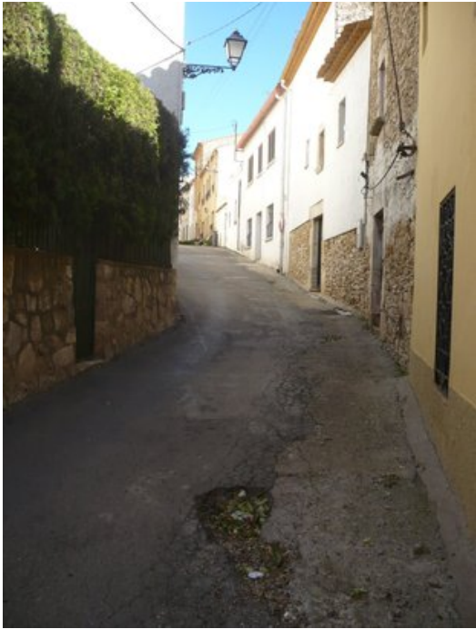
Mal estat del carrer de Vera. Foto: A.V.
