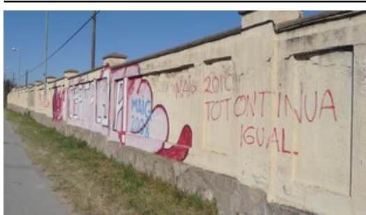
Diversos pintades denuncien els retards del projecte en la façana del solar on s'ha de fer de l'hospital. Foto: C.A.F.
