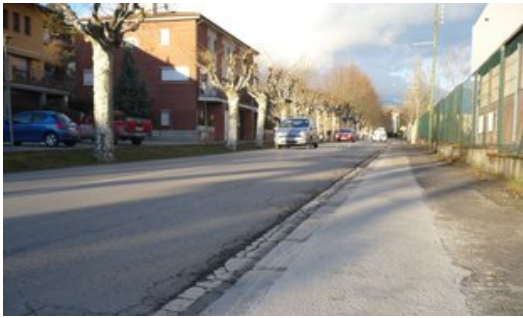
Una vista del tram de la Carretera de Sant Joan de les Abadesses de Ripoll, on ara s'inicien les obres. Foto: J.C.
