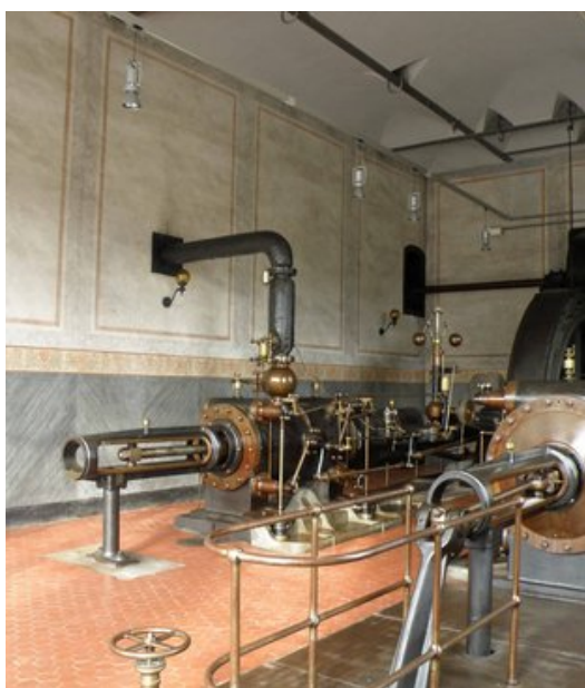
La sala on hi ha el vapor de la fàbrica Burés.
