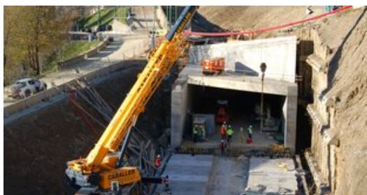
Una vista des de la carretera de Queralbs de les obres que es realitzen al pas subterrani. Foto: J.C.
