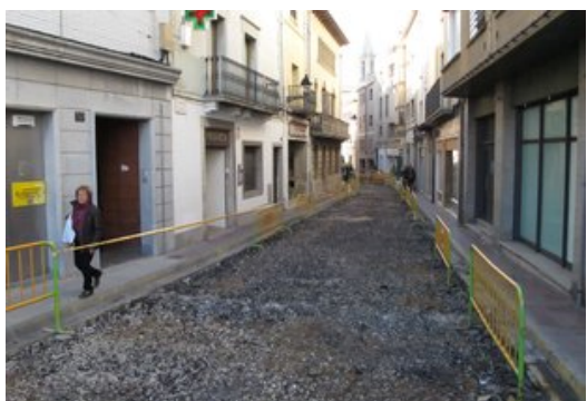
El carrer Major de Cassà amb el paviment aixecat per les obres Foto: J.N.
