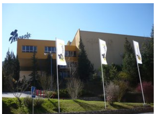
La façana de Casals Ventilació, de Sant Joan de les Abadesses. Foto: R.CARMONA.
