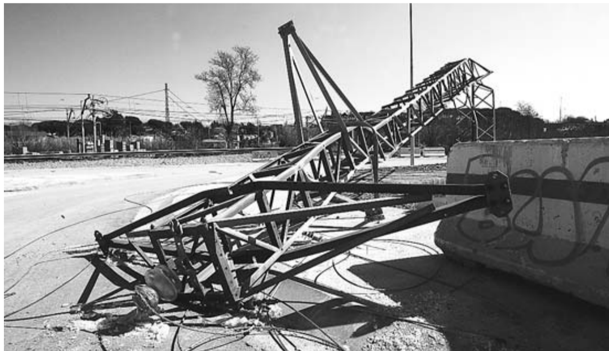
La caiguda de torres elèctriques, com aquesta de Fornells, ha estat la imatge de la nevada del dia 8. / MANEL LLADÓ
