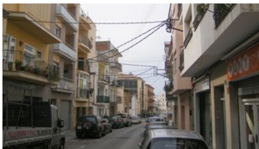
Línies elèctriques a Roses
