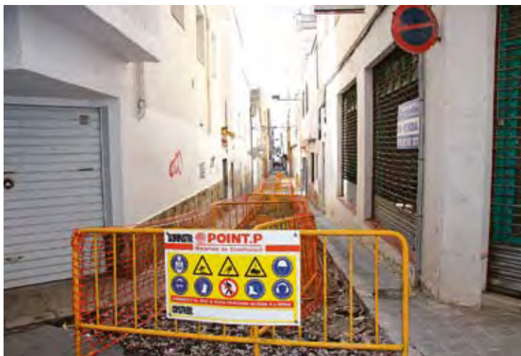
CARRER SANT PERE ALT. Un dels punts on es fan les obres
