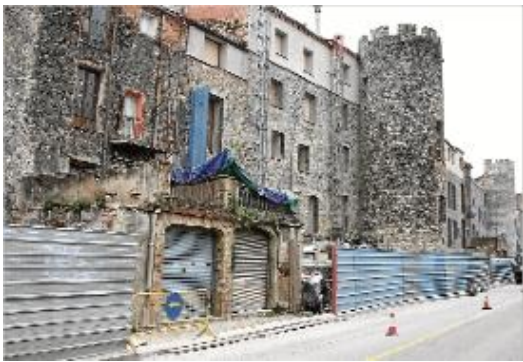
Aspecte d'un dels panys de muralla rehabilitat amb terrats dempeus.
