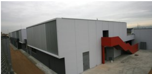
La nova escola que s'ha construït a Maçanet de la Selva. Foto: MANEL LLADÓ.
