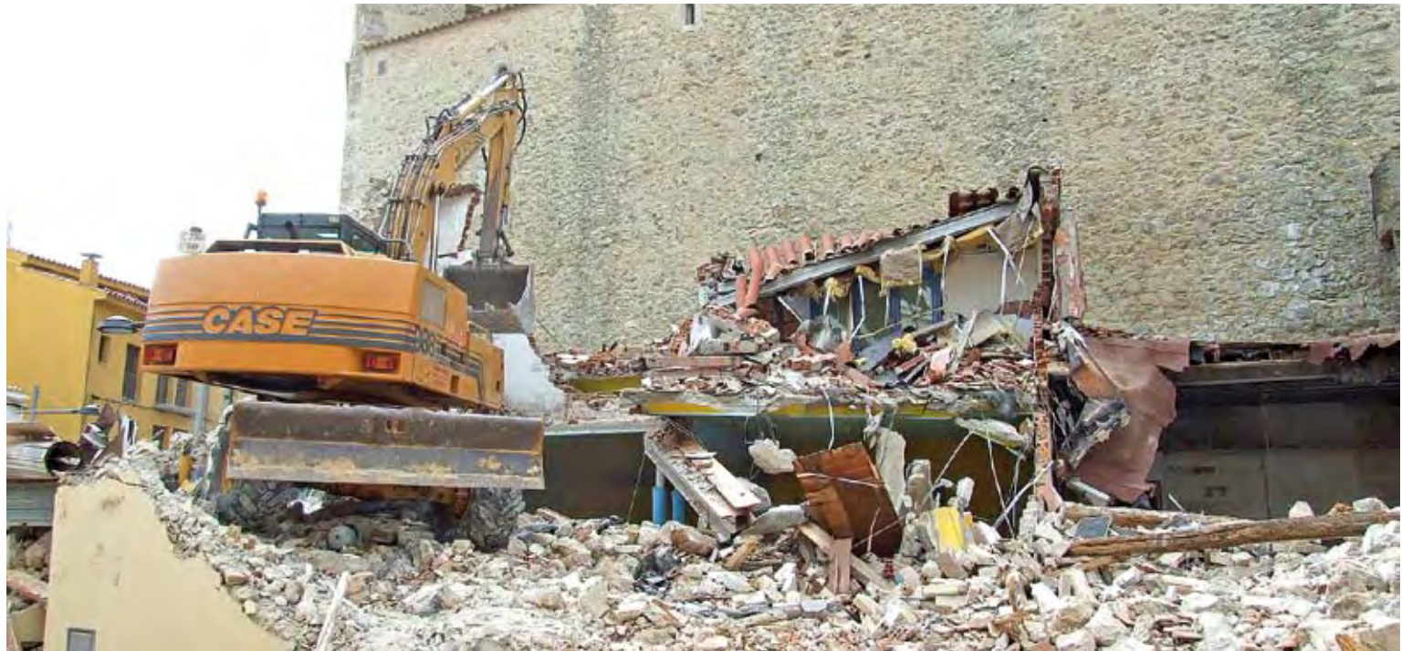
L'ENDERROC DE LA PLUMA. Els treballs han començat aquesta setmana i es preveu que acabin en els pròxims dies amb la retirada de runa
