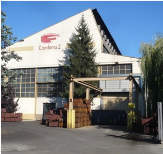
La façana de l'empresa metal·lúrgica de Ripoll Foto: J. CASAS.
