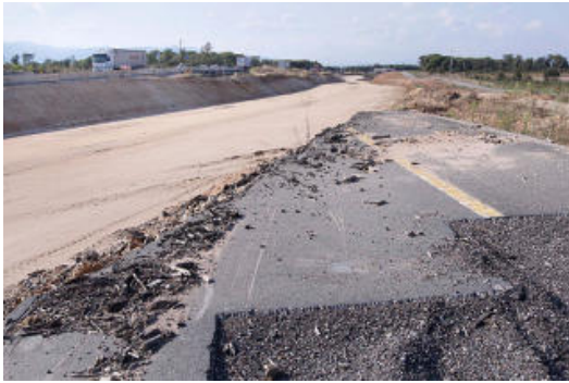
Estat en què van quedar les obres en aquest tram, en una imatge d'arxiu a Caldes de Malavella.
