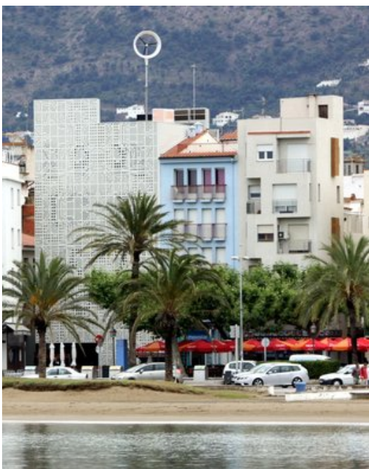
La façana del nou edifici de Ca l'Anita, amb el molí de vent instal·lat. Foto: EL PUNT.
