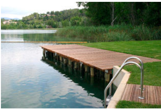
La zona de bany de la Caseta de Fusta, un cop reformada. <br/>
