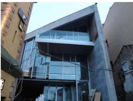
El nou Ajuntament de Castellfollit de la Roca.<br/>
