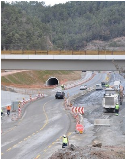
Detalls dels últims treballs que s'estan duent a terme a la carretera C17, a l'arribada ja a Ripoll. Foto: EL PUNT.
