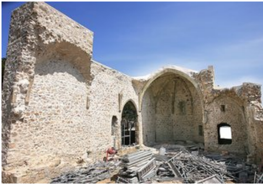
Les restes de l'església de la Vila Vella de Tossa, en obres, el 2007, on ja volien fer-hi un auditori Foto: MANEL LLADÓ.
