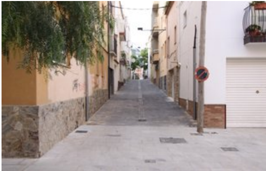
Una imatge del sector del carrer Nou, que ja s'ha rehabilitat. Foto: EL PUNT AVUI.
