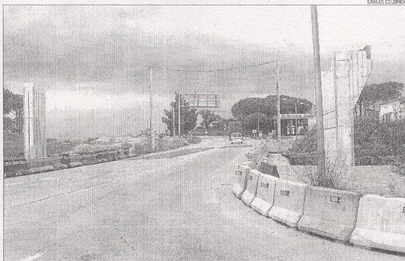
Estat que presentaven les obres de l'A-2 en el tram de Caldes de Malavella la tarda d'ahir.
