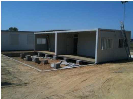
Una imatge de la construcció del mòdul prefabricat més que s'està instal·lant a l'escola rosinca. Foto: EL PUNT AVUI.
