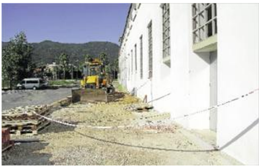
Una de les excavadores que ja treballa en les obres per enllestir la sala polivalent d'Anglès. <br/>
