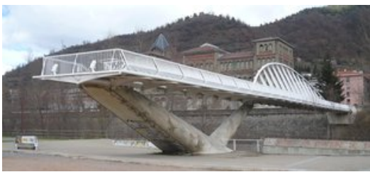
El pont vist pel costat en què s'han d'eliminar barreres, amb l'estació neoromànica del tren al fons. Foto: J.C.
