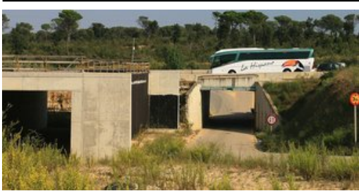
Estat de les obres de l'N-II entre Sils i Caldes, amb trams a mig construir des de fa dos anys. Foto: MANEL LLADÓ.
