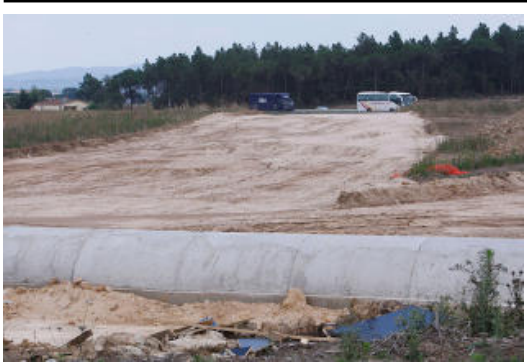
Les obres de la N-II segueixen aturades des que l'empresa adjudicatària va fer fallida.
