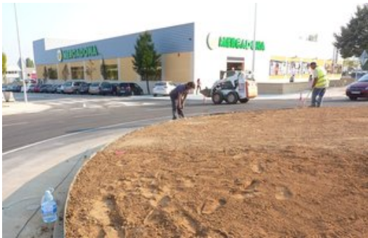
Exterior del Mercadona de Banyoles amb operaris fent els darrers retocs al giratori. Foto: R. E.
