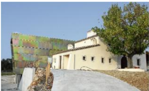
La Masia de Can Rafel s'ha rehabilitat del tot i compta amb un edifici adjacent fet de nou.<br/>
