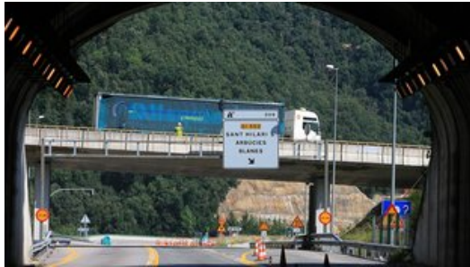
La carretera en obres a la sortida d'un túnel i abans de l'accés a Sant Hilari Sacalm i Arbúcies. Foto: MANEL LLADÓ.
