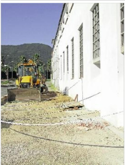
Una de les màquines treballant a l'estiu per condicionar la sala.<br/>
