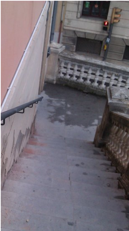
Una imatge d'una de les baranes instal·lades. Foto: E.M.
