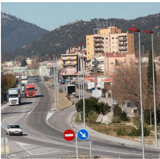
Una imatge de la carretera N-II a la Jonquera, amb l'enllumenat públic. Foto: EL PUNT AVUI.
