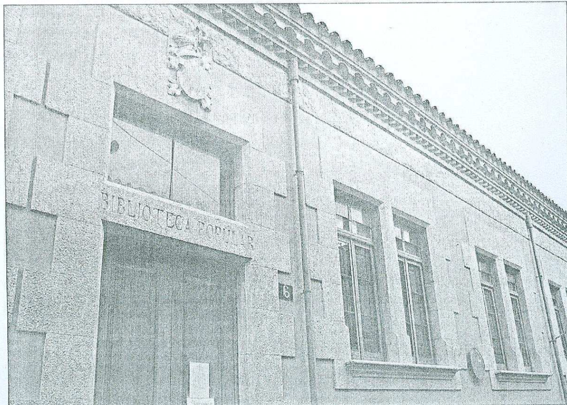
Biblioteca. L'edifici té pendent des de fa quasi dos anys la instal·lació dels aparells d'aire condicionat.
