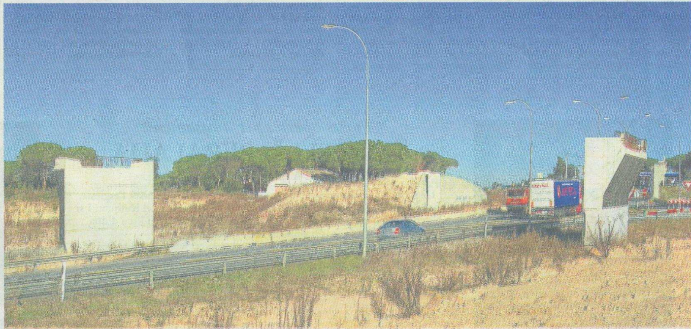
Les obres del desdoblament de la N-II estan aturades des de fa temps per manca de finançament
