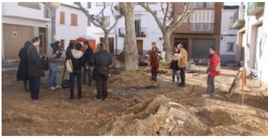
L'alcalde, Carles Pàramo, va fer ahir una visita d'obres a la plaça Prim, on s'ha localitzat el refugi antiaeri. Foto: EL PUNT AVUI.
