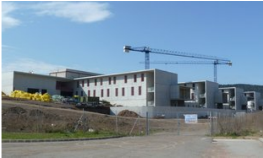
Aspecte del nou hospital d'Olot que encara està en procés de construcció, en una imatge d'arxiu. Foto: JORDI CASAS.
