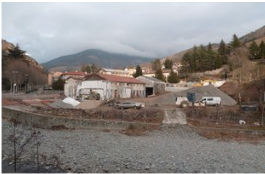
Una vista dels terrenys on s'està construint una de les dues noves zones d'aparcament. Foto: J.C.
