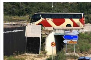
Les obres de l'N-II a mig fer entre Sils i Caldes. Foto: MANEL LLADÓ.
