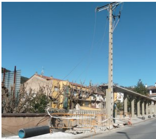
Un detall dels treballs, que ara es fan a l'altura de la vorera de l'Ajuntament de Sant Joan. Foto: J.C.
